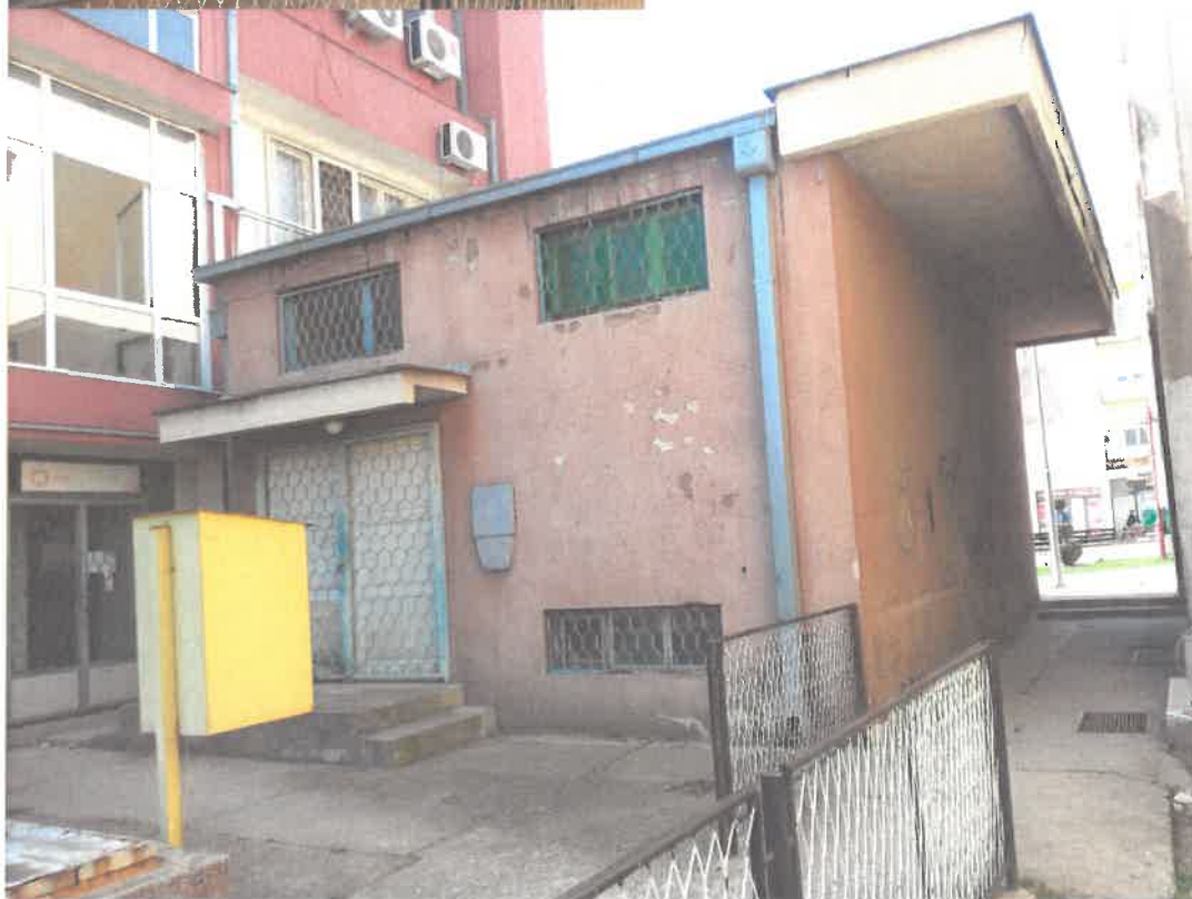
ДВОРИШНА ФАСАДА СА КОТЛАРНИЦОМ
