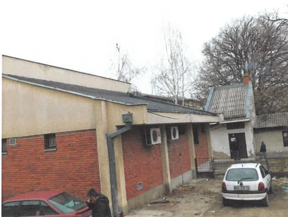
ЈУЖНА - ЗАДЊА ФАСАДА ПОШТЕ
