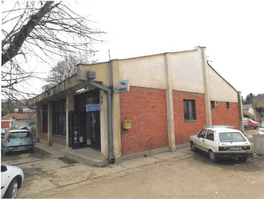
СЕВЕРНО ЗАПАДНА - ПРЕДЊА ФАСАДА ПОШТЕ
