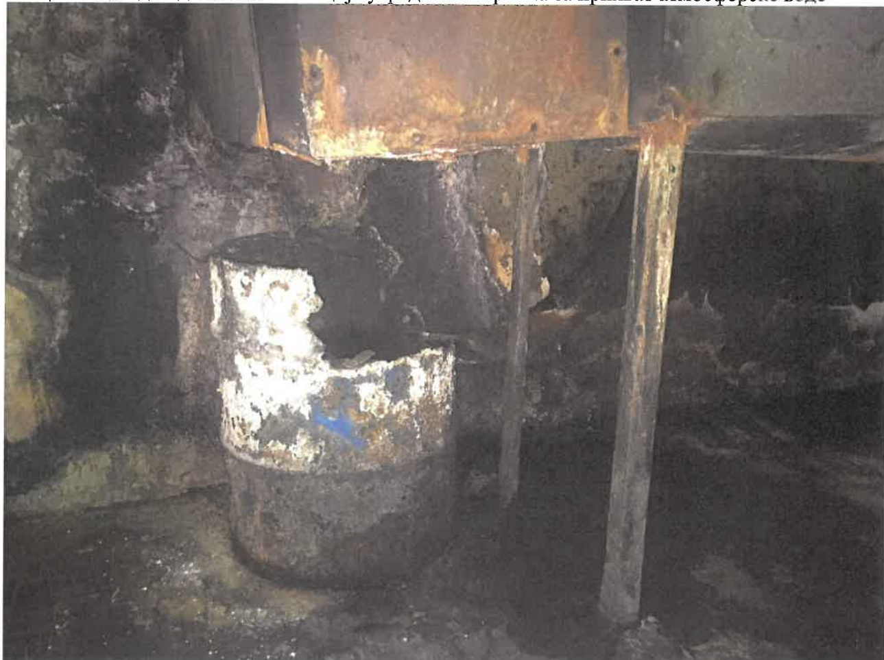
ТКЦ Ужице - дно димњака - позиција уградње сабирника за прихват атмосферске воде
